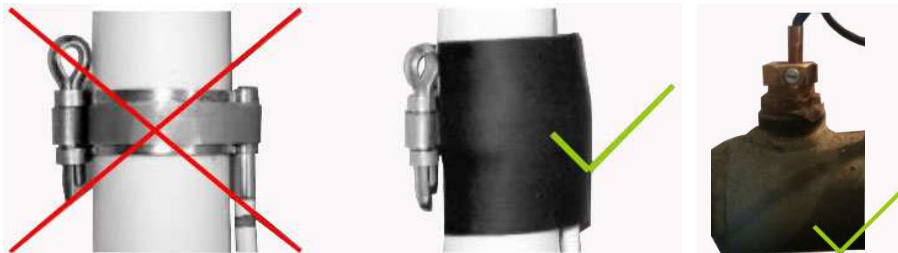
Obr. č. 8 – zapojení teplotních čidel
